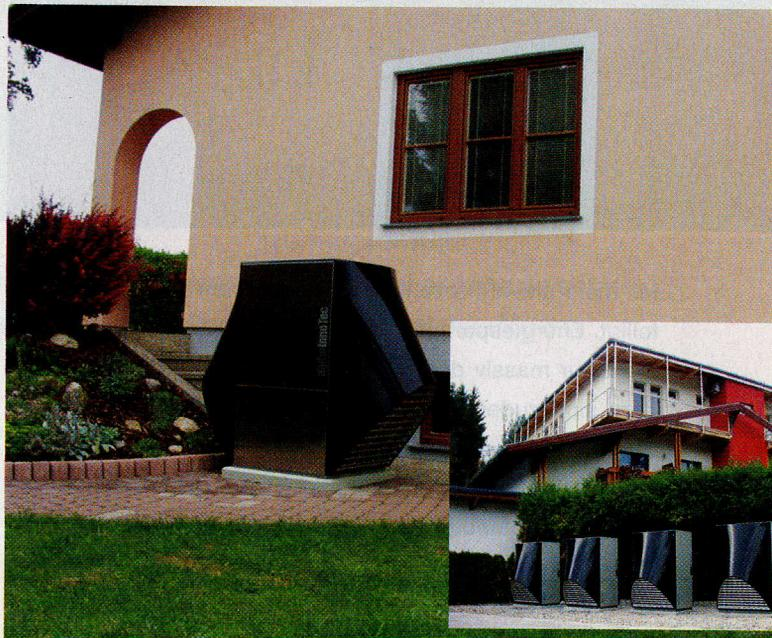
Heizungs-Sanierung: Die Luft/Wasser-Wärmepumpe ersetzt 3.500 m<sup>3</sup> Erdgas pro Jahr im Einfamilienhaus... und 35.000 Liter Heizöl pro Jahr im Hotel. In beiden Fällen wurden die jährlichen Heizkosten um mehr als 50% reduziert !
